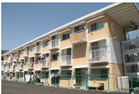
女川町は土地が狭いため 3階建ての仮設住宅も
