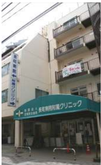
外観では被害の状況はわからない
