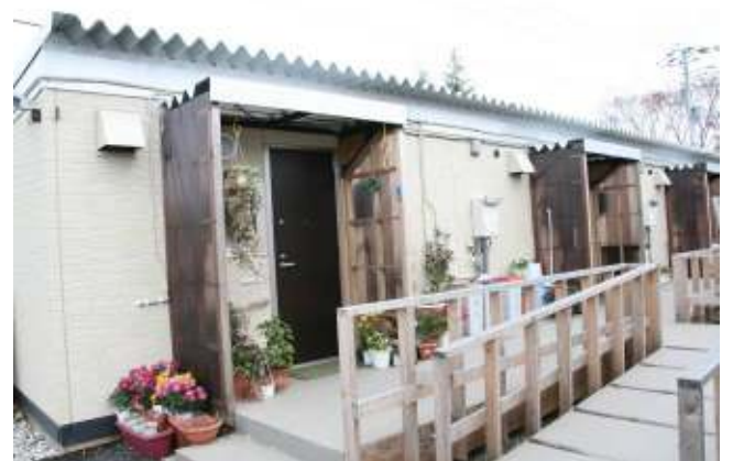
大谷中学校の仮設住宅。暖房はエアコンが設置されているが、電気カーペット・ストーブ、コタツ、石油ストーブの中から2つ選ぶことができる。2重窓サッシの工事が急ピッチで行われていた。
